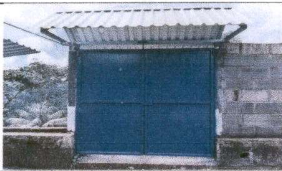
Foto 5: Cambio de portón de metal.
