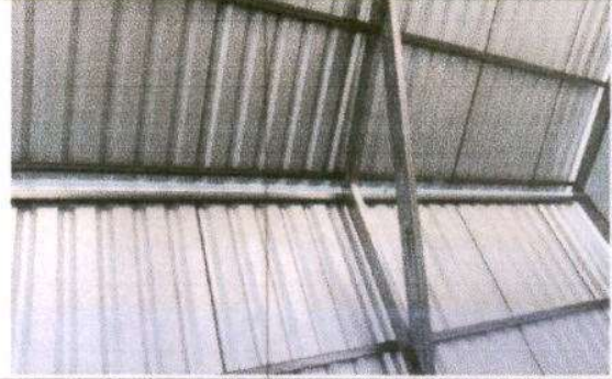
Foto 2: Sustitución de estructura de madera por metal.
