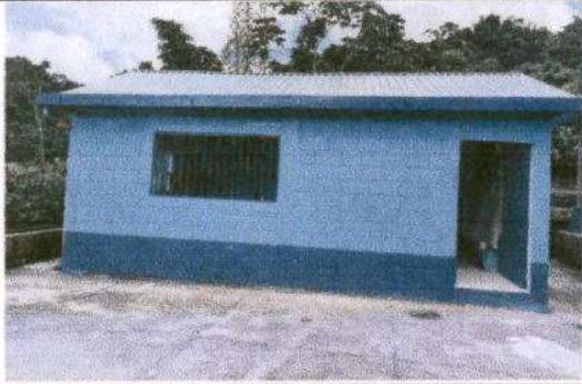
Foto1: Sustitución de cubierta de lámina troquelada Aluzinc.
