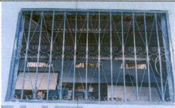
Foto 4: Sustitución y fabricación de balcones de metal.
