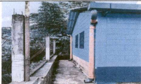
Foto 3: Sustitución de canal y bajadas de agua pluvial e instalación de puerta de metal de las aulas.
